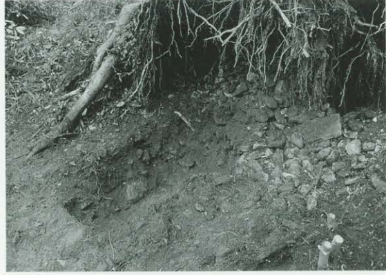
2 大市墓根起き箇所No.24 (西から)
