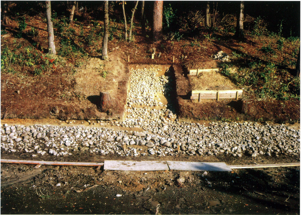
1 狭城盾列池上陵 第19トレンチ 全景(西から)
