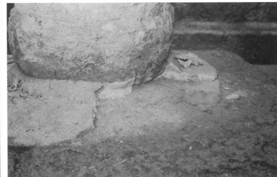
6 宇倍野陵墓参考地 昭和39年調査 石堂石柱基部モルタル撤去状況
