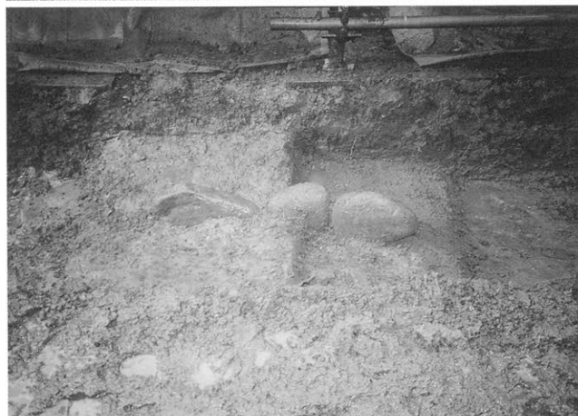
4 宇倍野陵墓参考地 北地中梁設置箇所 配石4（北より）
