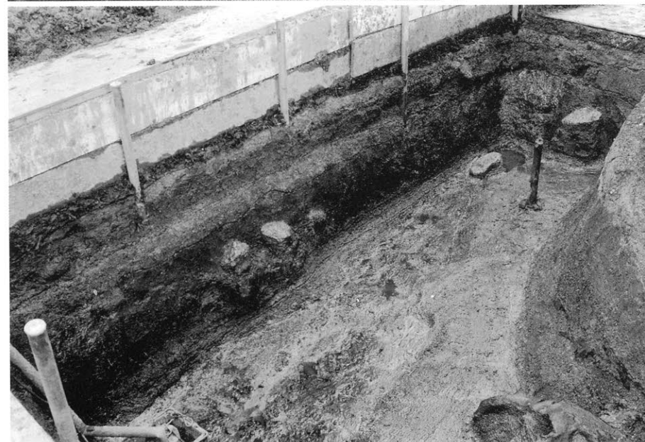
3 埴口丘陵 第10トレンチ 完掘状況
