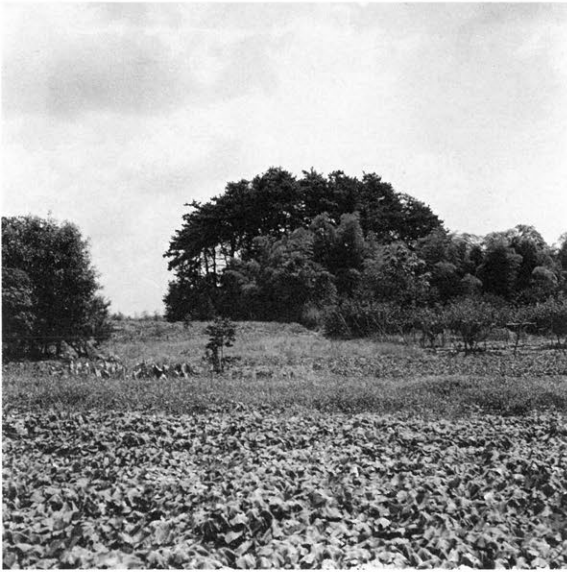
1 北堤と墳丘 遠景（北から）
