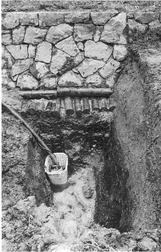
1 埴口丘陵 第14トレンチ 完掘状況
