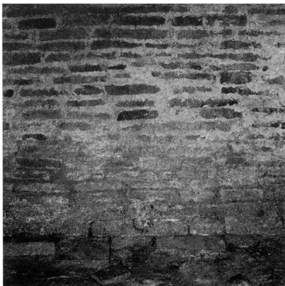
5 玄室 西壁詳細（東から）
