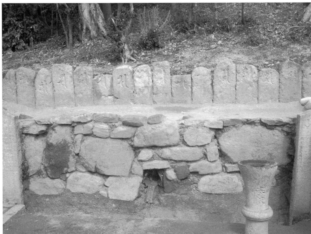
2 磯長墓 結界石据え直し箇所 北壁
