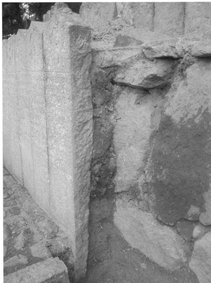
1 磯長墓 結界石据え直し箇所 西壁
