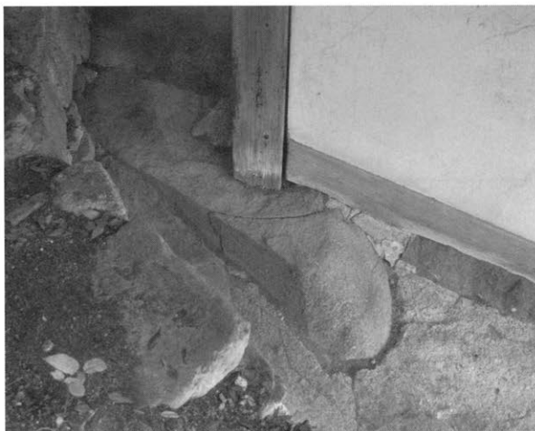
6 磯長墓 石室天井石露出状況（南西から）
