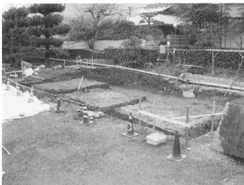
7 嵯峨東陵 部事務所基礎掘削箇所 全景 (北東から)
