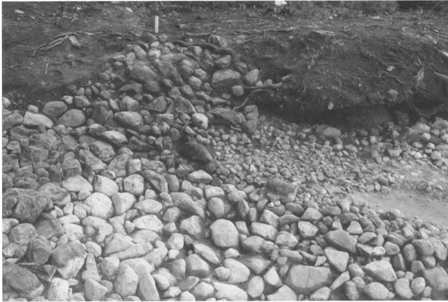
1 第16トレンチ 造出側斜面葺石(東半部) (北から)
