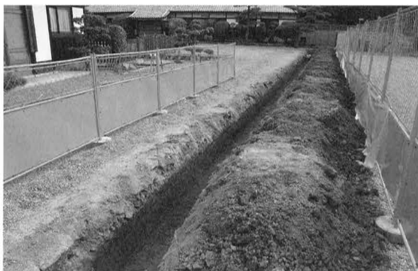
2 第1トレンチ 全景（西から）
