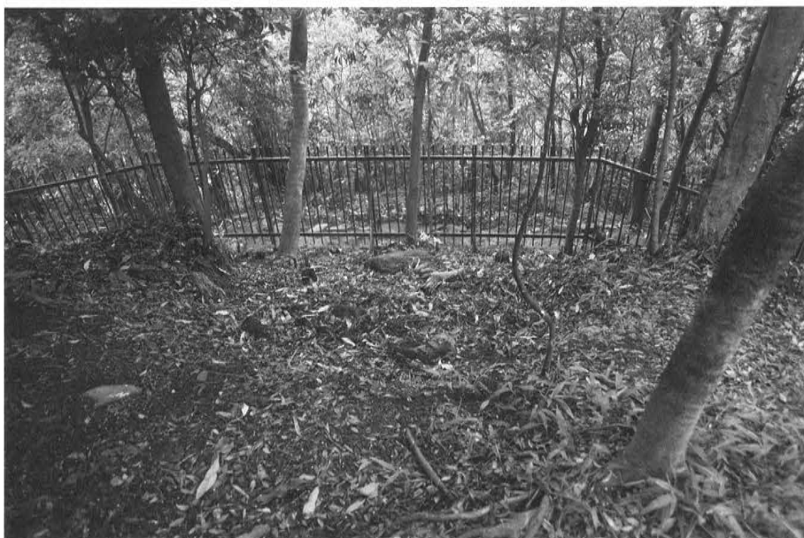
2 墳丘東側崩落箇所 (西から)
