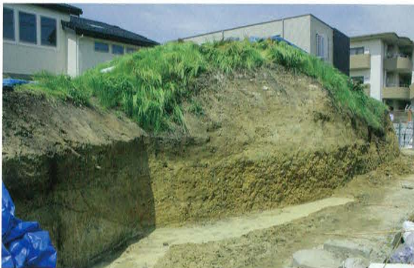
2 南壁（北東から）
