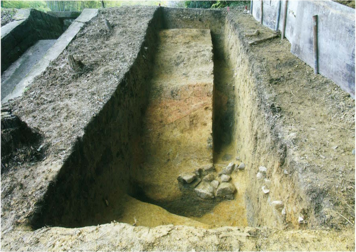
1 第8トレンチ 全景 (西から)
