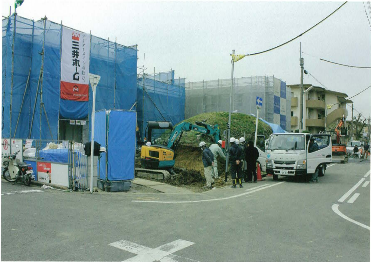
1 調査地全景（北東から）
