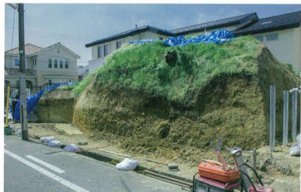
3 南壁（北西から）
