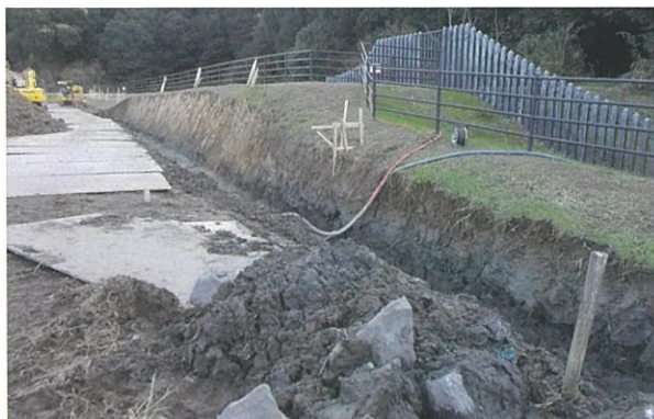
1 石積工箇所 界 11 号付近から (東へ)
