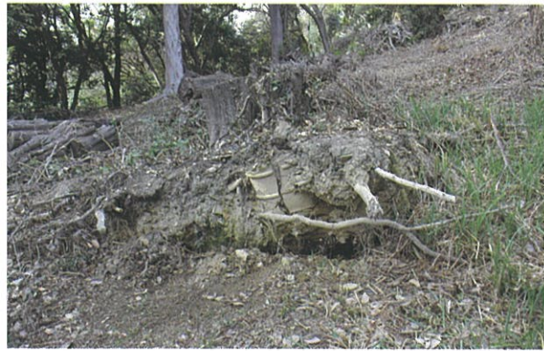
2 根起き箇所1 全景 調査時 (南東から)
