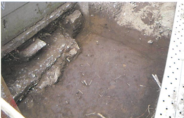
6 Iブロック掘削箇所（南から）
