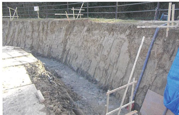
2 石積工箇所 界 13 号付近から (東へ)
