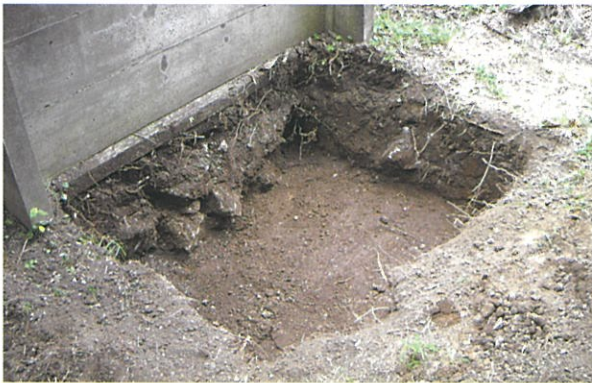
4 Cブロック掘削箇所（東から）
