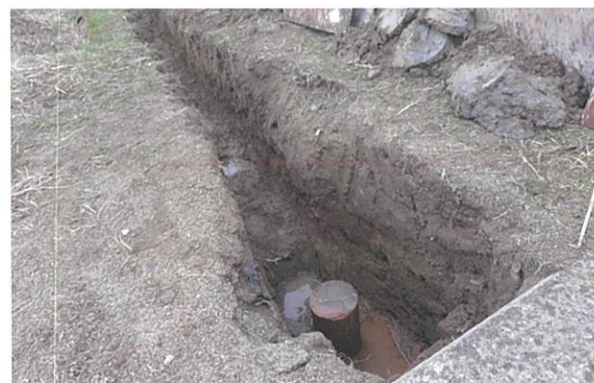
8 排水工箇所 ウ区 (西から)
