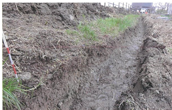
7 排水工箇所 ア区 (東から)
