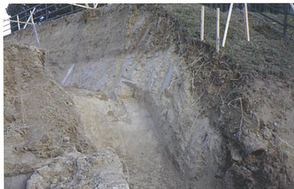
4 石積工箇所 界 17 号付近から (東へ)
