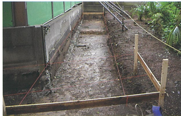
5 EFブロック掘削箇所（東から）
