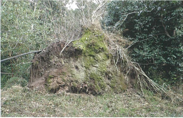
1 調査箇所全景（南西から）
