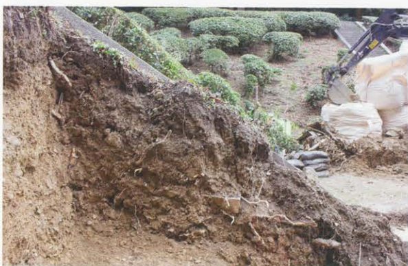
2 斜面下箇所東壁北側（西から）
