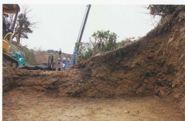
3 斜面下箇所南壁（北東から）
