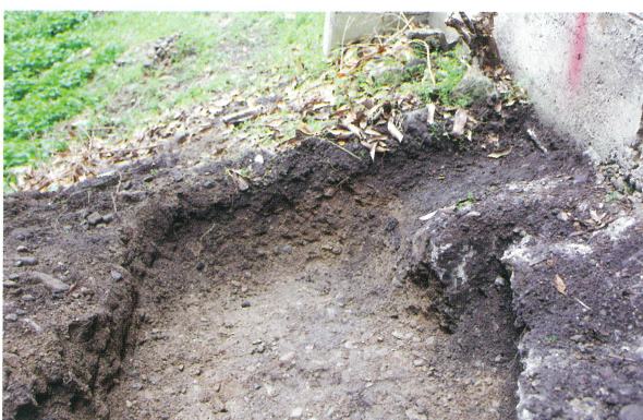
6 北側掘削箇所 B 地点（東から）
