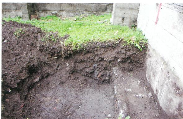
4 北側掘削箇所 A 地点（東から）
