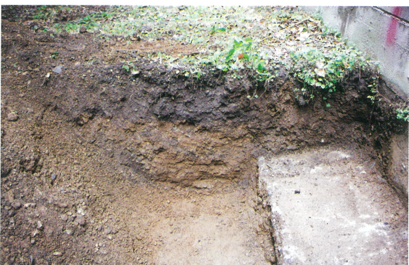
8 北側掘削箇所 C 地点（東から）
