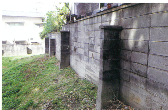
2 境界標識 18 号付近（東から）
