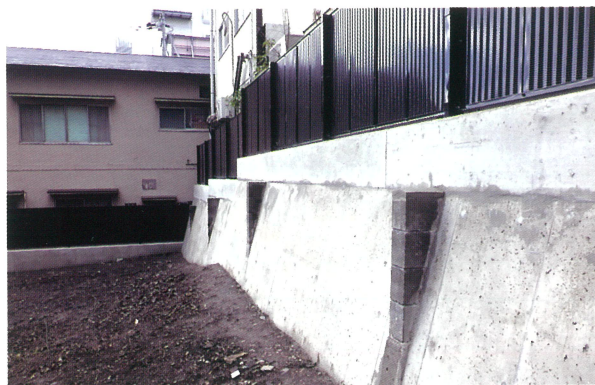
7 工事後 境界標識18号付近（東から）
