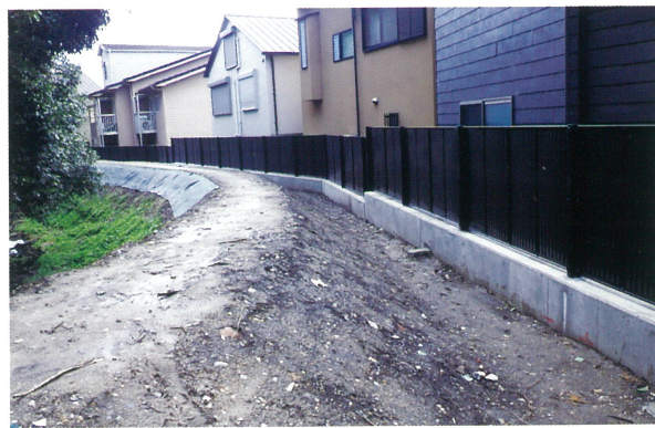
6 工事後 境界標識15号付近（北から）
