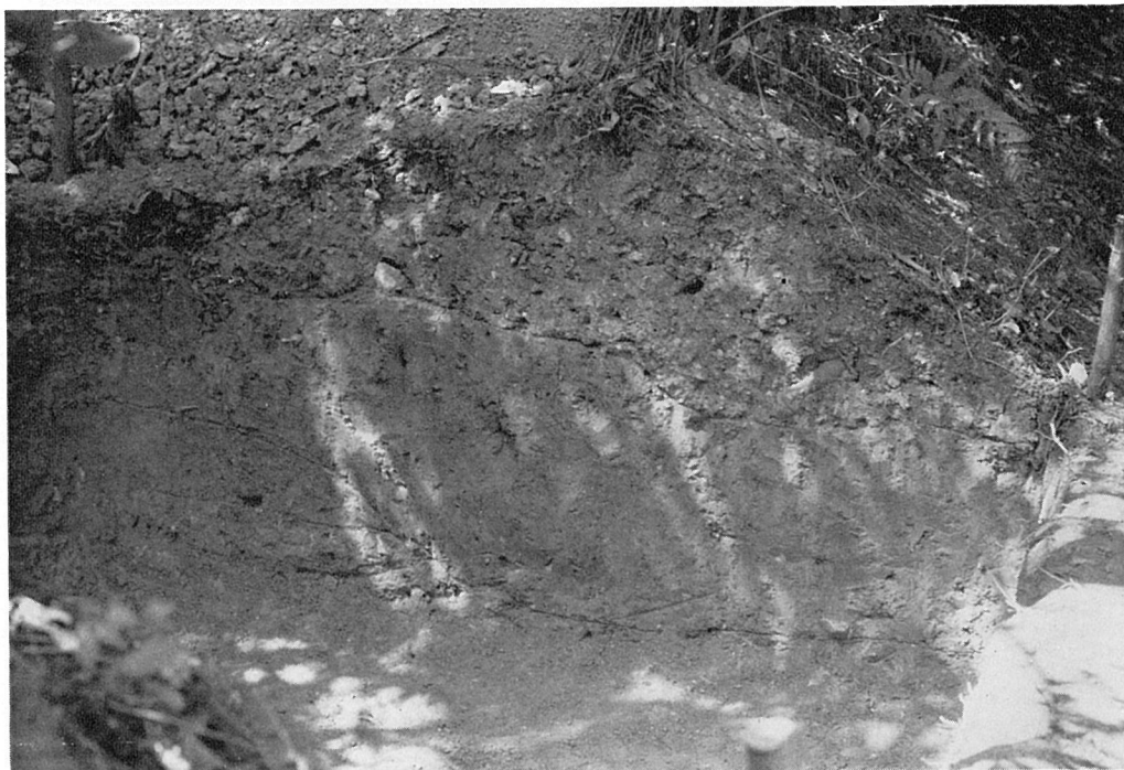
1. 鳥戸野陵 第18トレンチ 土堤盛土状況
