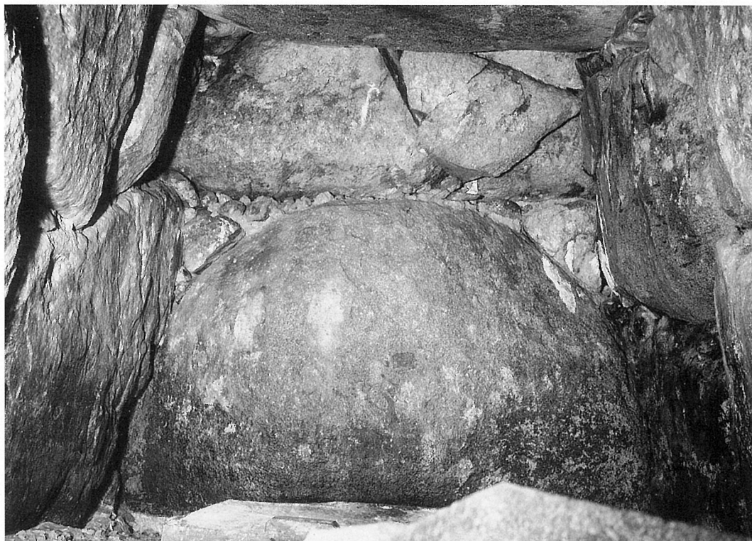
畝傍陵墓参考地横穴式石室奥壁（南から）
