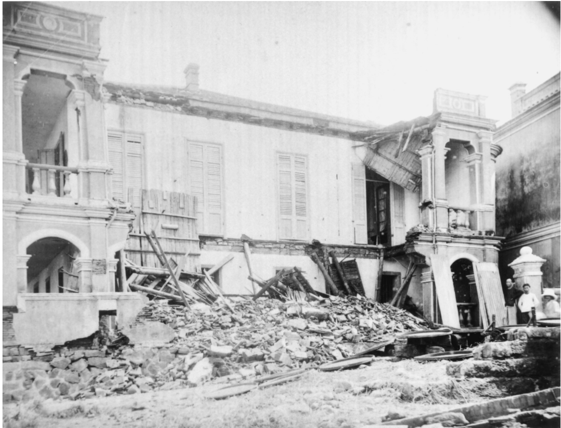
(写真3) 二、台湾風水害写真 「在大稻埕独商德記洋行破損ノ惨状」
