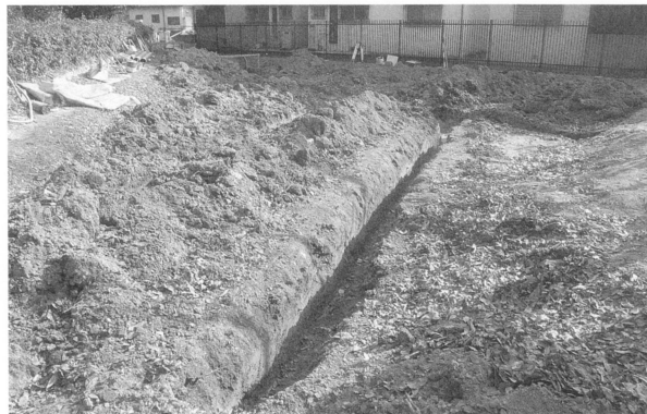
2 第1～7トレンチ 掘削状況（北西から）
