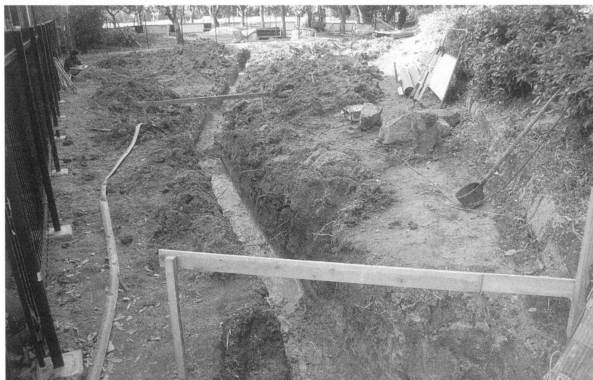
1 第1～7トレンチ 掘削状況（東から）
