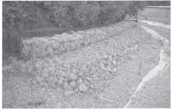
4 布団籠設置状況
