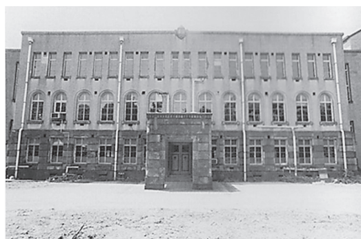
図2 昭和2年に竣工した図書寮庁舎 (旧江戸城本丸跡、平成7年 中村一紀氏撮影)
