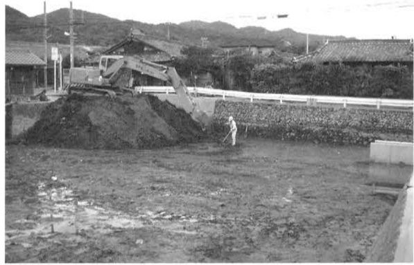
2 堆積土除去工事実施状況（北東から）
