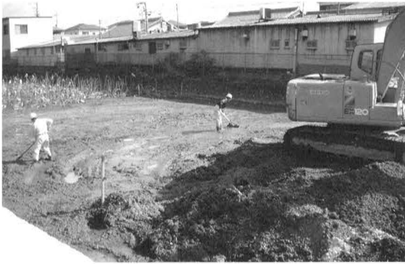
1 堆積土除去工事実施状況（北西から）
