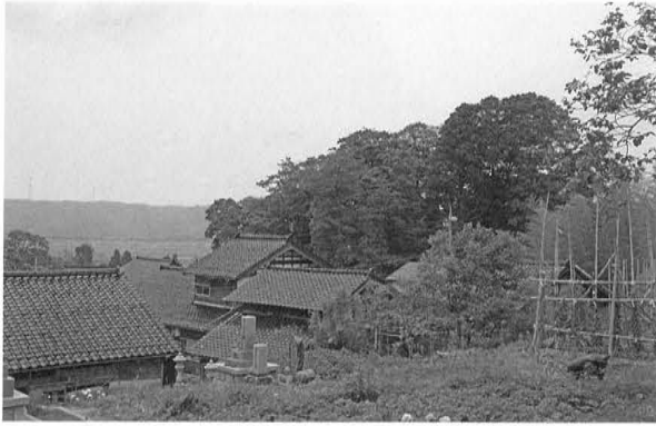
1 遠景（南東から）
