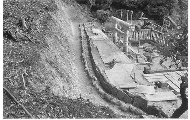
2 排水溝全景（西から）
