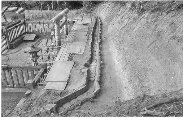
1 排水溝全景（東から）
