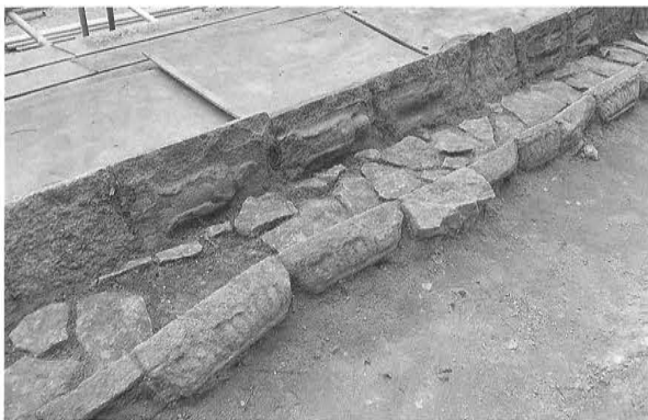
5 排水溝中央付近（北東から）
