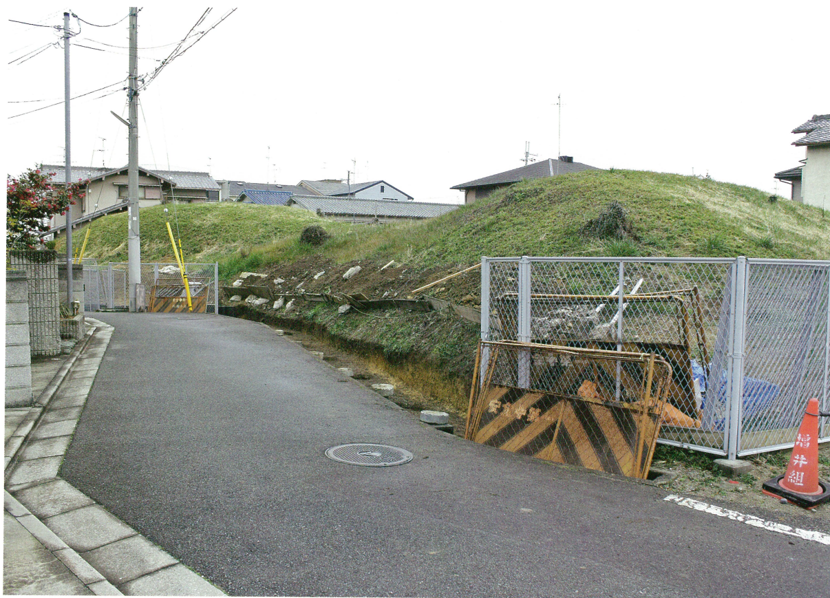
1 調査地(A-C間)全景(北西から)
