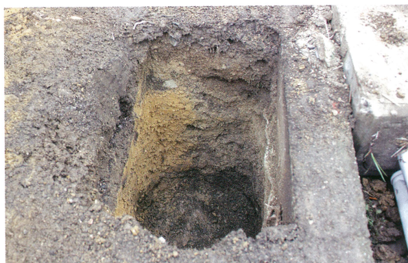
2 調査地(A-C間)②西壁(東から)
