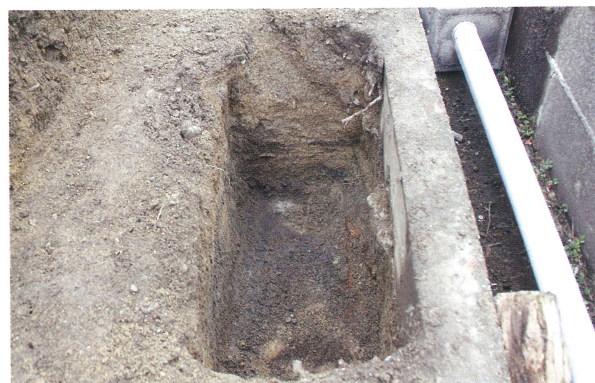
4 調査地(A-C間)④西壁(東から)
