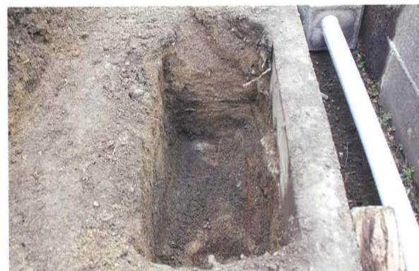
4 調査地(A-C間)④西壁(東から)
