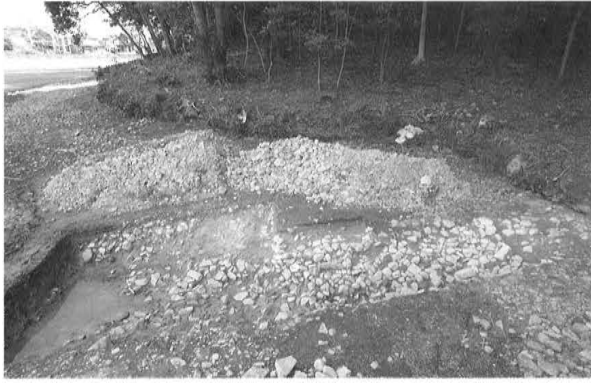
1 第13トレンチ 全景(西から)
