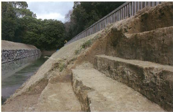
2 第2トレンチ北壁（南から）
