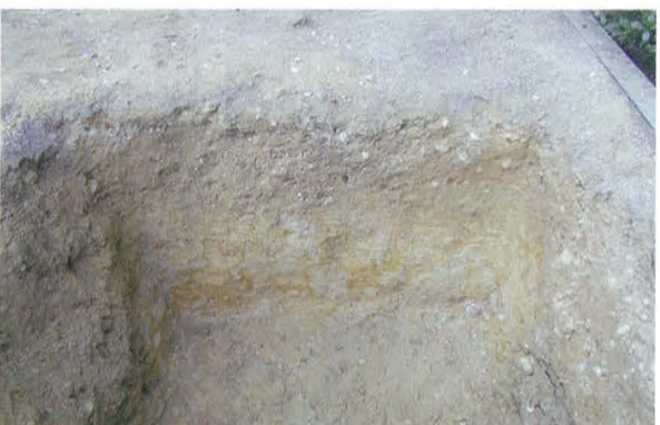
7 西柱基礎 西壁（東から）
