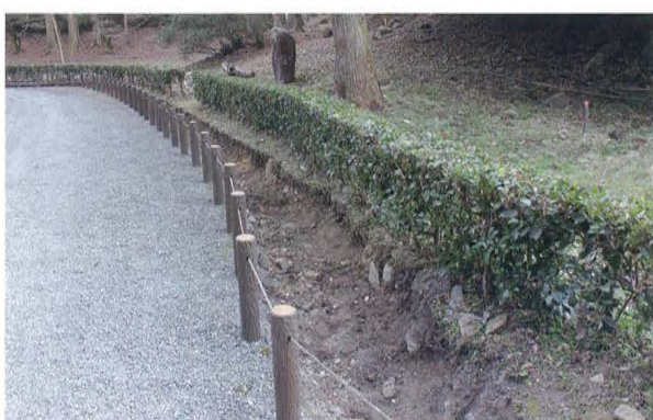
5 D区北壁（北西から）
