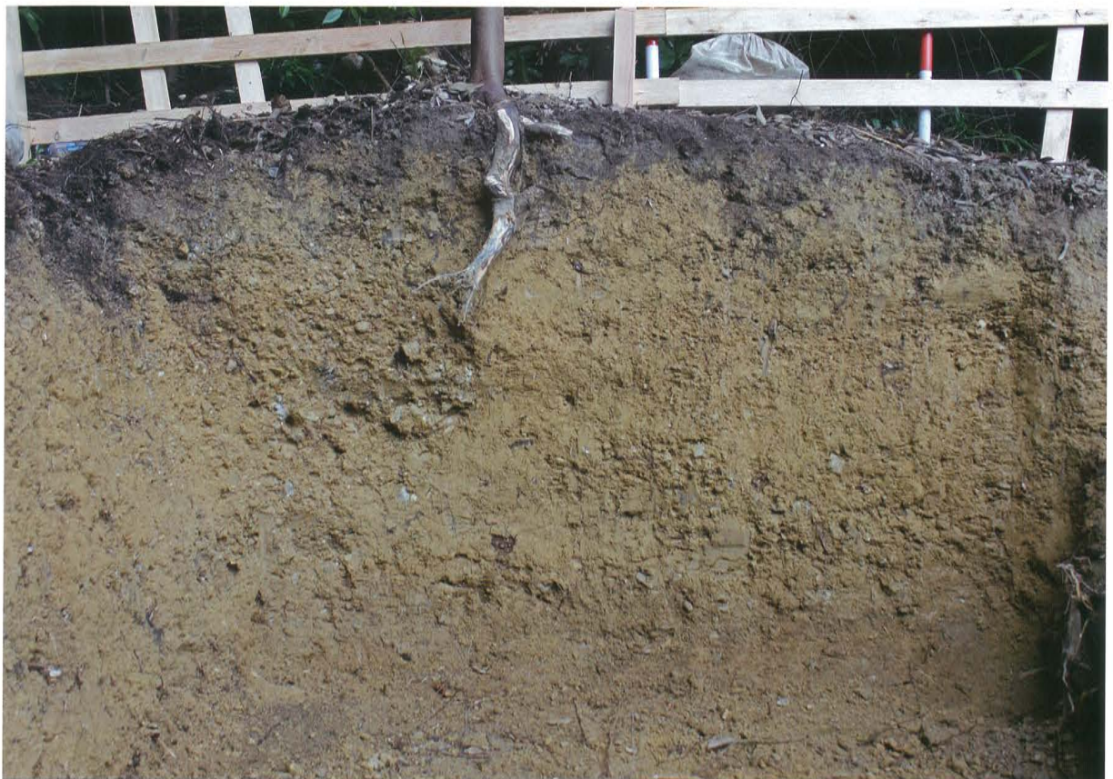
2 重力式擁壁南側南壁（北から）
