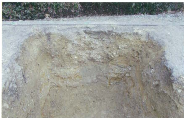
1 東柱基礎 北壁（南から）
