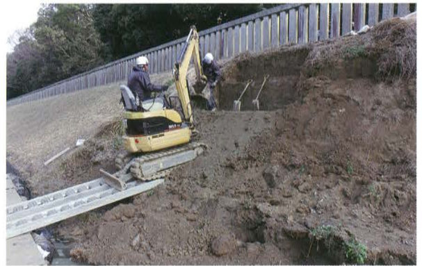
3 第2トレンチ工事掘削（南西から）
