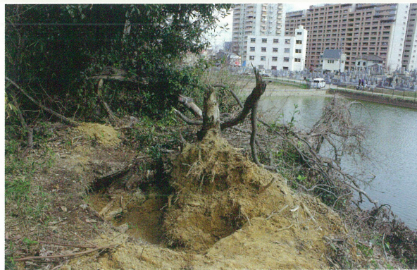
2 根起き箇所1 調査過程全景（南から）
