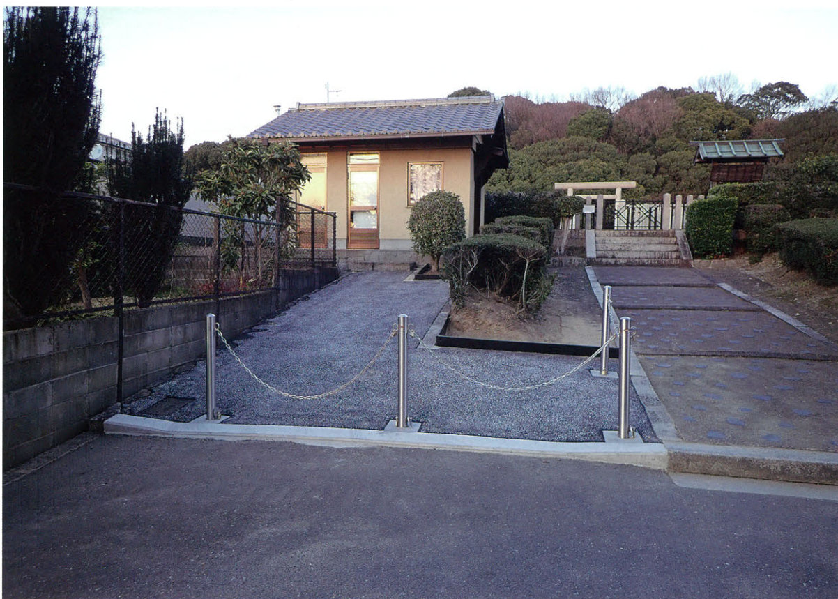
2 竣工後全景(南西から)
