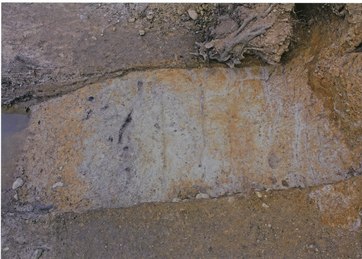
2 第1トレンチ 下部全景(西から)
