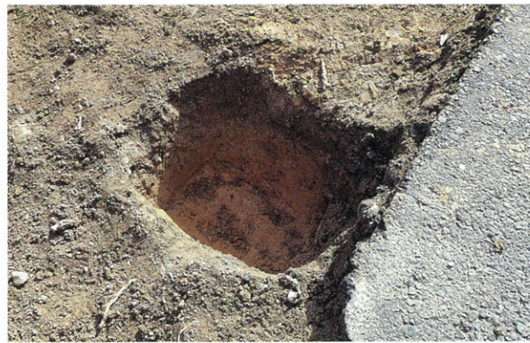
3 車止め2(西から)
