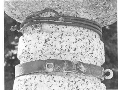
3 現況写真（相輪上部、北東面）
