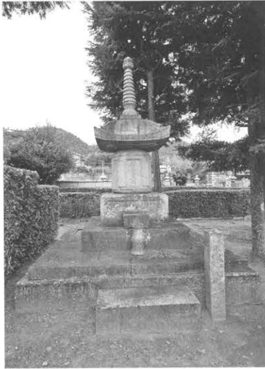
1 現況写真（南正面）
