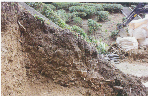
2 斜面下箇所東壁北側（西から）
