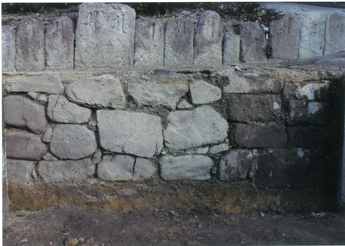
1 西区 全景（南から）
