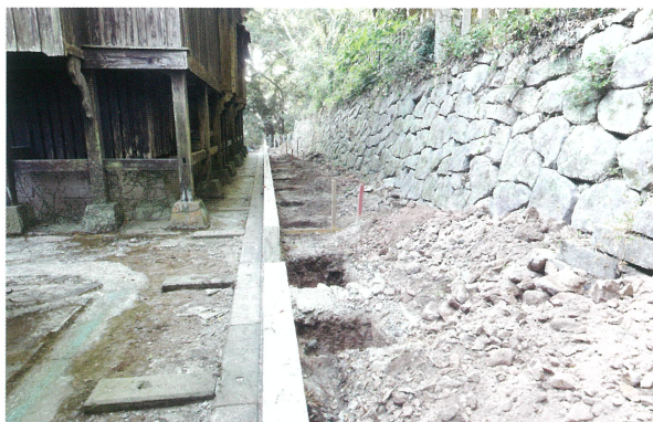
2 掘削後写真（東から）
