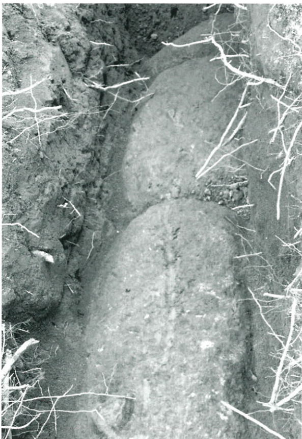
4 裾舗石 護石角部石積状況 東北東角 (13-16)
