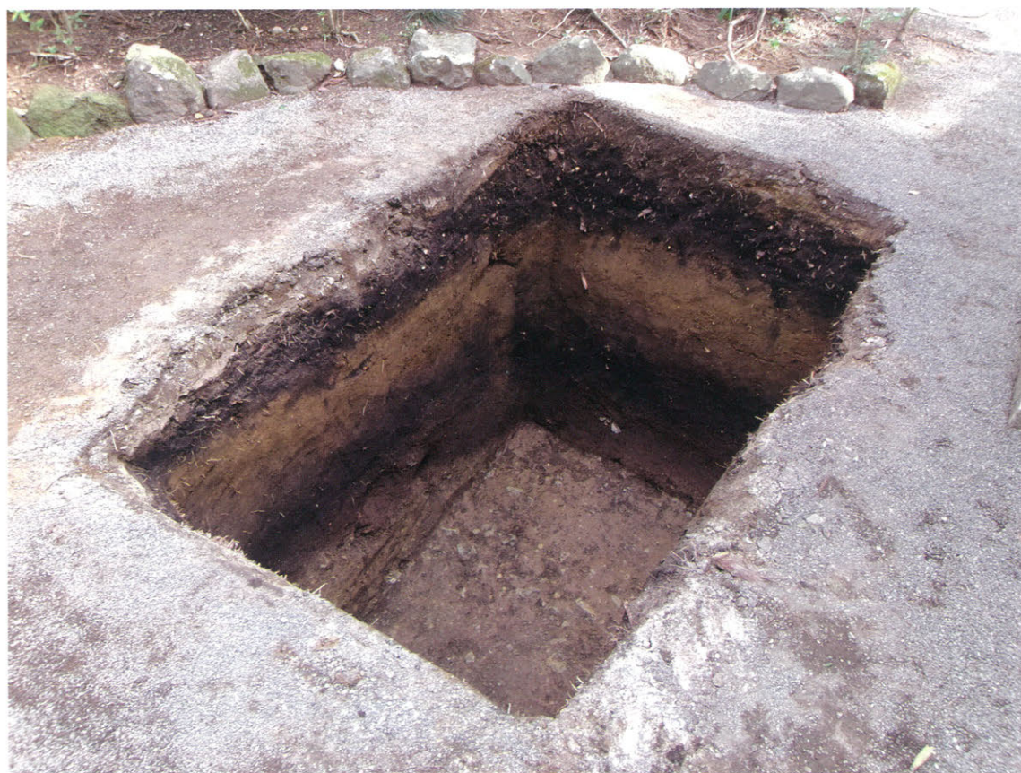
2 新規浄化槽設置箇所 南壁・西壁（北東から）
