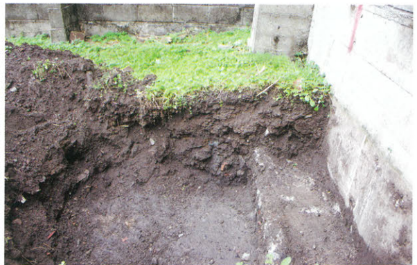
4 北側掘削箇所 A 地点 (東から)
