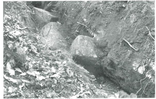
6 北部舗石 上 崩落石 (12-29)
