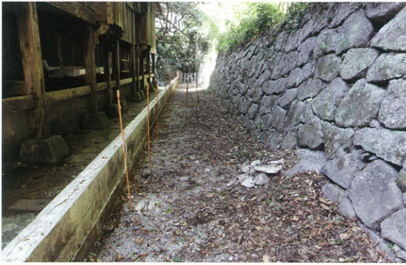
1 掘削前写真（東から）
