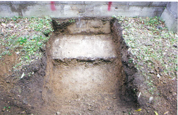
7 北側掘削箇所 C 地点 (南から)
