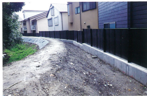
6 工事後 境界標識15号付近（北から）
