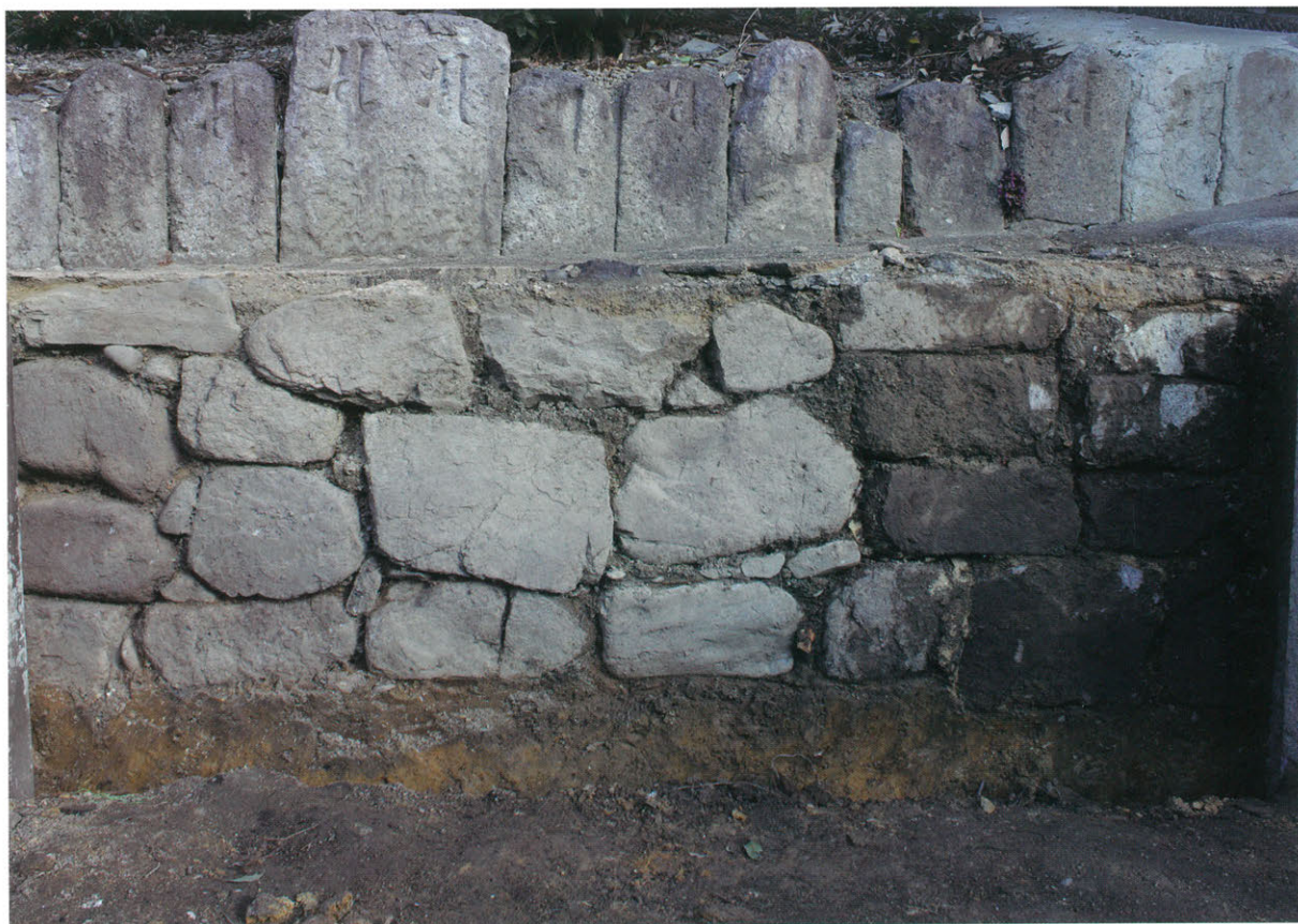
1 西区 全景（南から）
