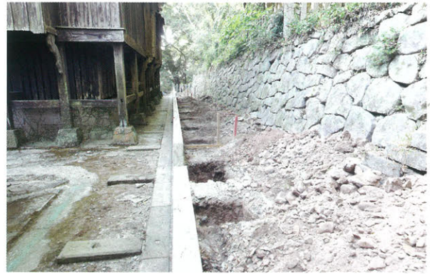
2 掘削後写真（東から）
