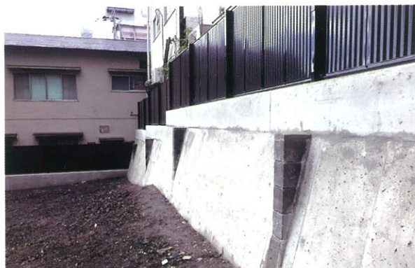
7 工事後 境界標識18号付近（東から）
