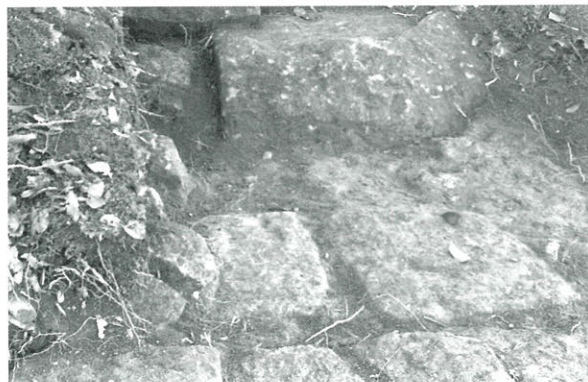
7 舗石・護石地覆北北東角(北北西角か) (12-33)
