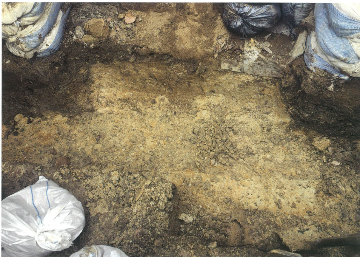
1 復旧工事立会箇所 地山掘削状況（南から）
