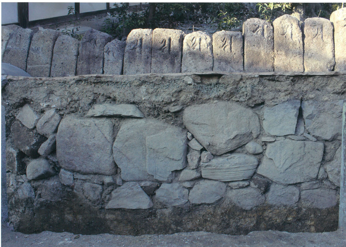
1 東区 全景（南から）
