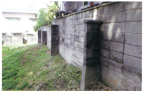
2 境界標識 18 号付近 (東から)
