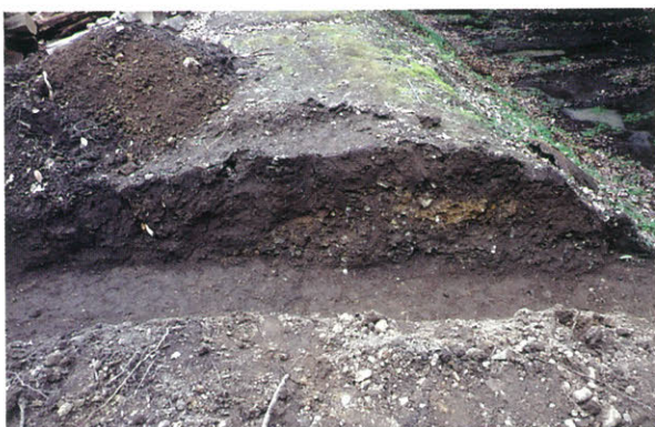
5 東側排水管設置箇所（北から）
