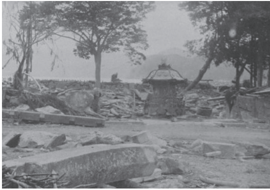
【モノクロ図版④】6月28日～7月2日頃 国府留蔵撮影 〔諸国災害実況写真〕(宮内庁書陵部図書寮文庫所蔵。函 架番号 B9・33)
