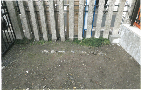
4 北箇所掘削前（東から）
