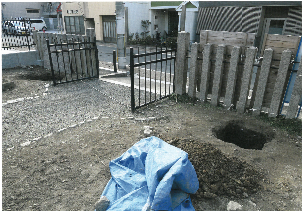
5 浸透枅設置箇所掘削状況（北東から）
