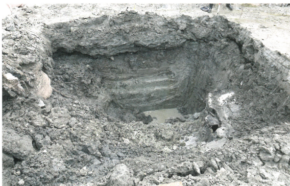
7 掘削部分 南壁 (北から)
