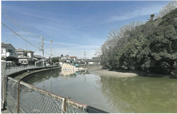
1 調査箇所 工事前 (南から)
