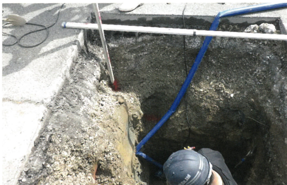
2 ガス管等確認工事 外堤上面の掘削状況（西から）
