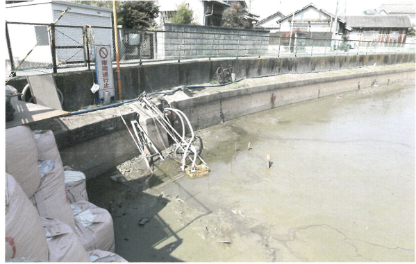
2 調査箇所 地盤改良前 (東から)
