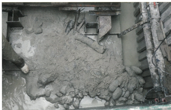
6 推進工事中出土 外堤西側斜面葺石か
