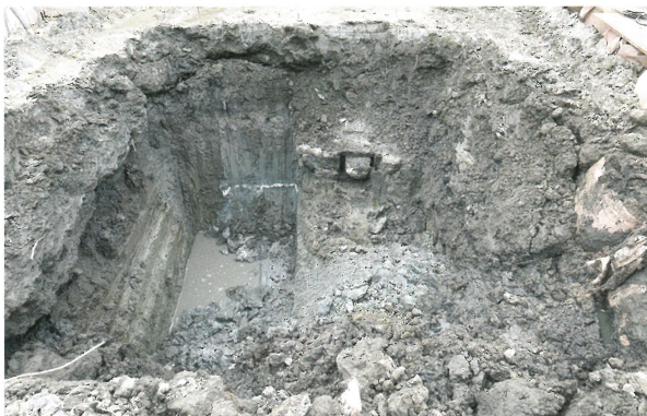
5 掘削部分 西壁 (東から)
