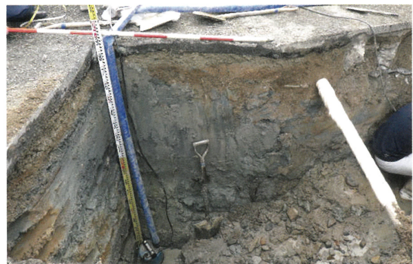
5 樋管貫通箇所 外堤下側掘削状況（西から）
