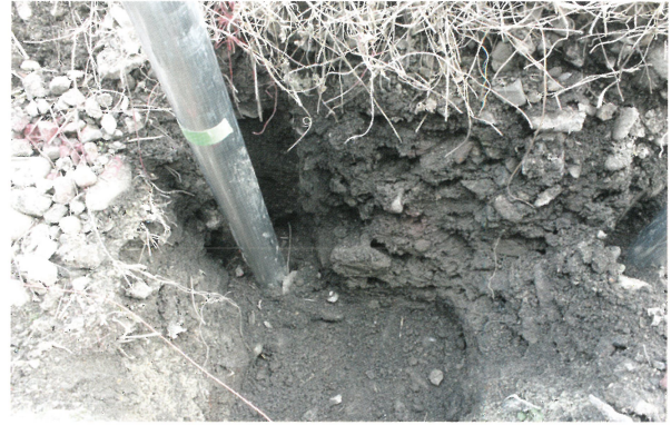
2 調査箇所 No. 2（南から）
