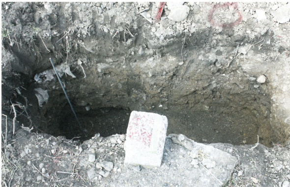
3 調査箇所門扉 B・No. 7・No.8（東から）
