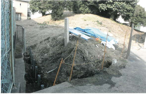
1 調査地全景（南東から）
