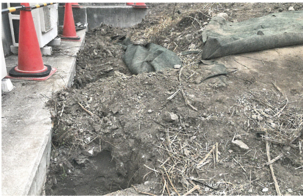
5 第⑮地点より第⑰地点（西から）
