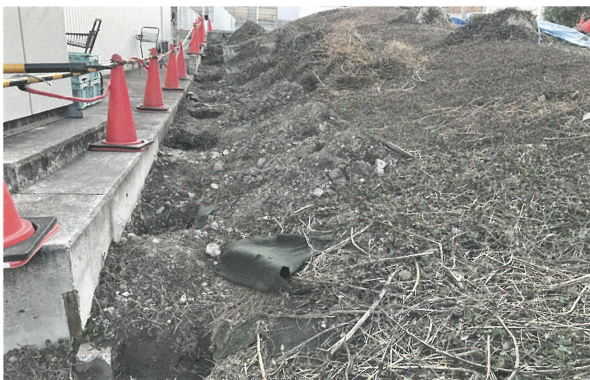
7 第⑲地点より第⑳地点（西から）
