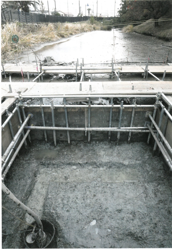
1 第2トレンチ全景（南西から）
