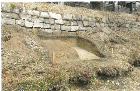
4 第3トレンチ 全景 (西から)
