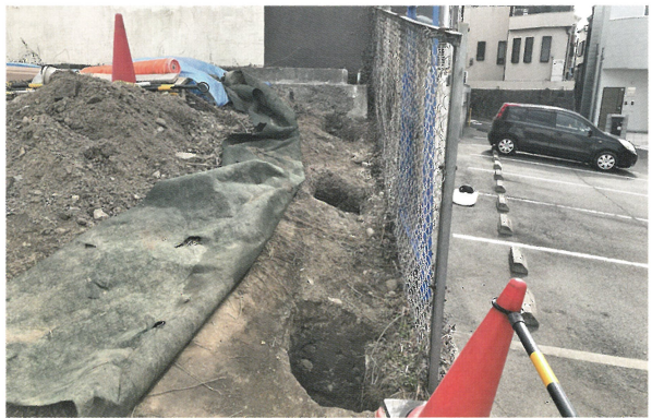
4 第⑬地点より第⑪地点（北から）
