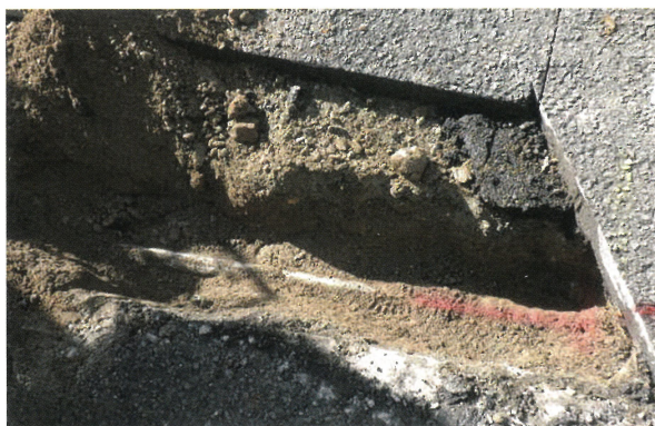
4 ガス管等確認工事外堤外側斜面下掘削状況（北から）
