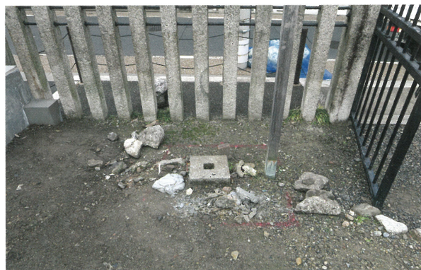
3 南箇所掘削前（東から）
