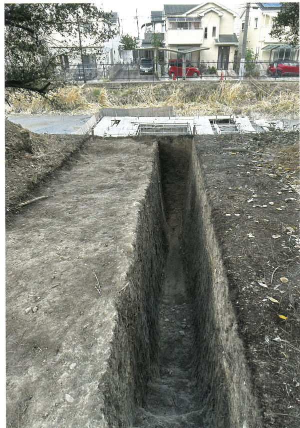
5 第7-2トレンチ断ち割り（南東から）
