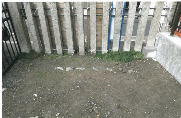
4 北箇所掘削前（東から）
