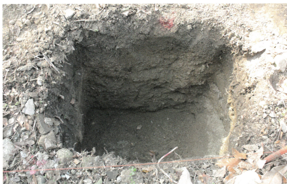
7 調査箇所 No.16（東から）
