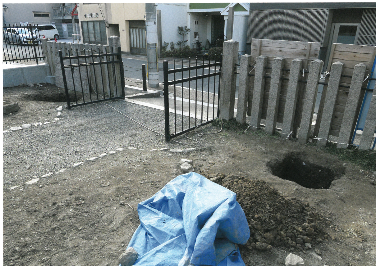
5 浸透枡設置箇所掘削状況（北東から）
