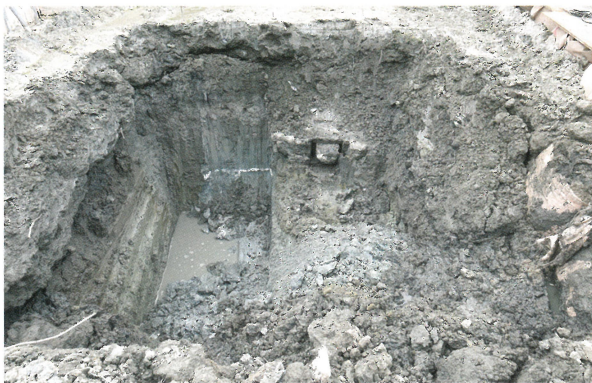
5 掘削部分 西壁 (東から)
