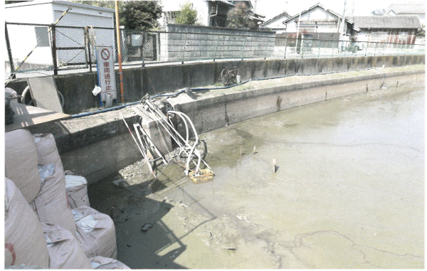
2 調査箇所 地盤改良前 (東から)
