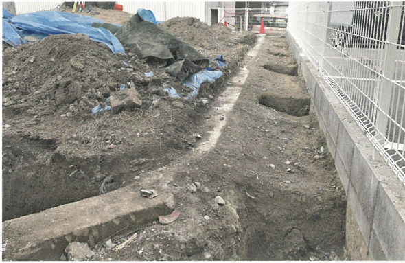
1 第⑦地点より第①地点（南から）
