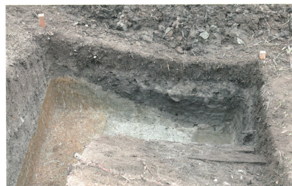
6 第4トレンチ 南側断ち割り 西壁
