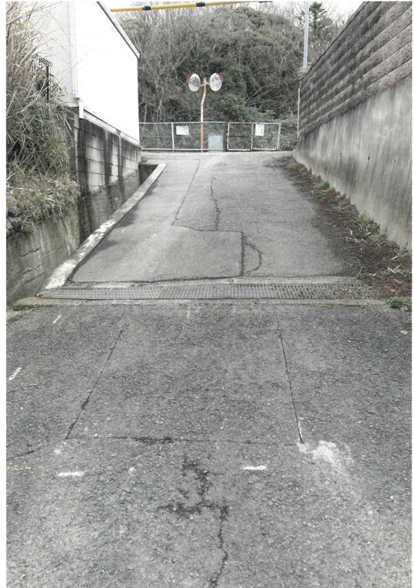
3 外堤外側斜面（西から）
