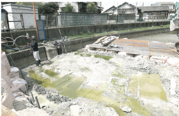
3 調査箇所 地盤改良後 掘削前 (東から)
